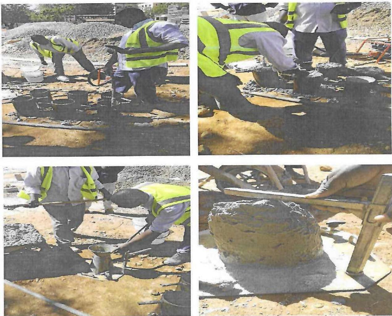
Prélèvement du béton pour vérification de la formulation (par le LNBTP)
